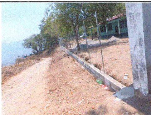
Foto 3: Se observa la colocación de la estructura metálica para el perímetro del establecimiento educativo.
