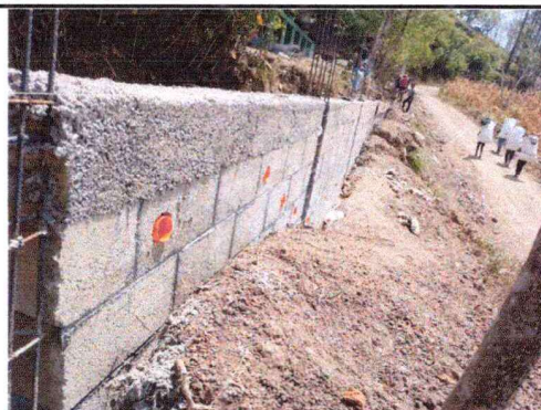
Foto 2: Vista del perímetro que se está remozando.
