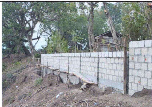
Foto1: Se observa la estructura de concreto perimetral en construcción.
